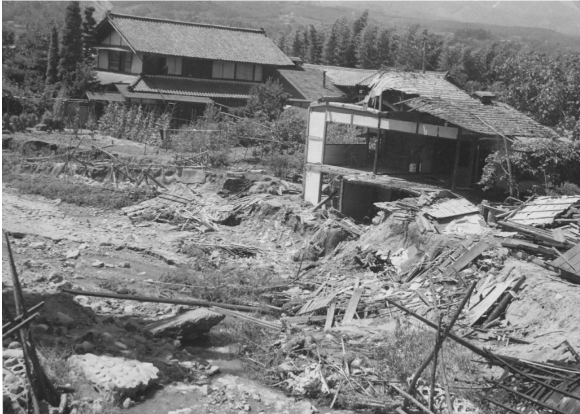
(No.2) 鉄砲水に荒らされ付近の住宅を飲み込んだ。
