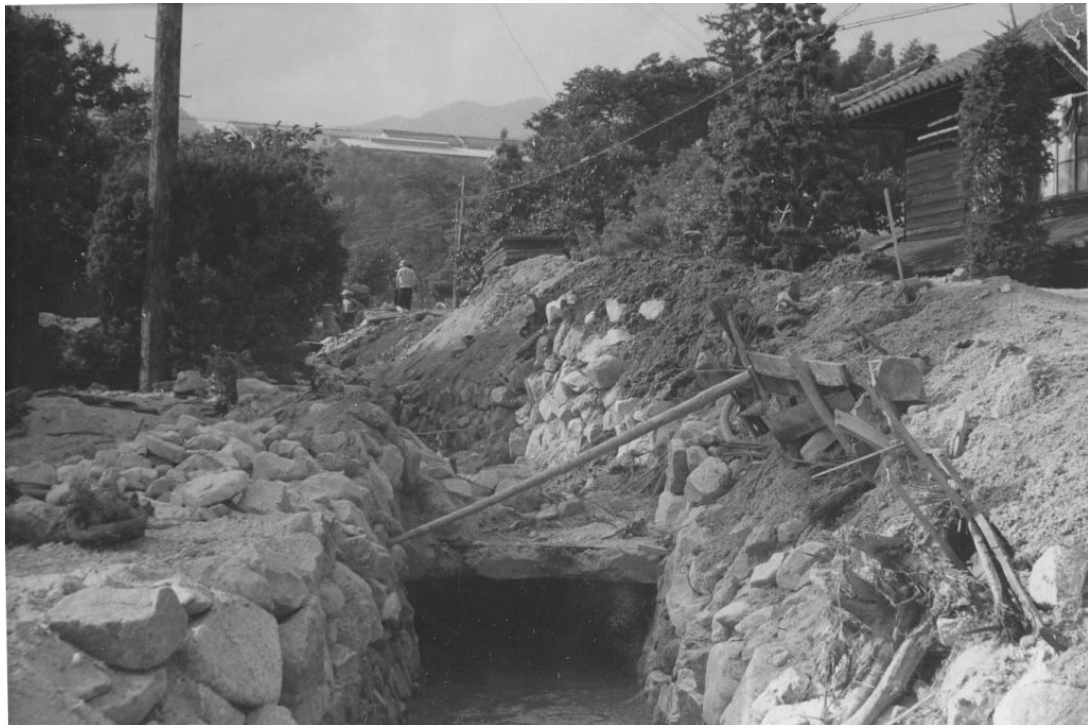
(No.1) 今宮神戸神社への参道に当たる 現今宮球場入り口道路に堆積した土砂、遠景には飯田風越高校が見える。
