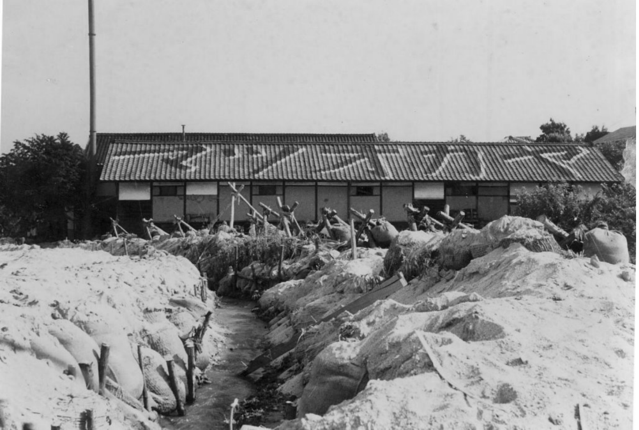
(No6) 氾濫する松洞川の川筋沿いに何とか食い止め田圃を越えて工場やその下の住宅街に達しないよう、杭を組んで土嚢で抑え守った跡が見える。マツオカヤ が見える建物は 味噌の速醸造蔵である。現在も同じ建物が立つが、新道計画に伴い、Yahoo 地図の駱駝屋さんの横に車の出入り口を開いている。
